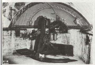
Fort Airolo. 8,4-cm-Ringrohrkanone mit hydraulischer Bremse.
