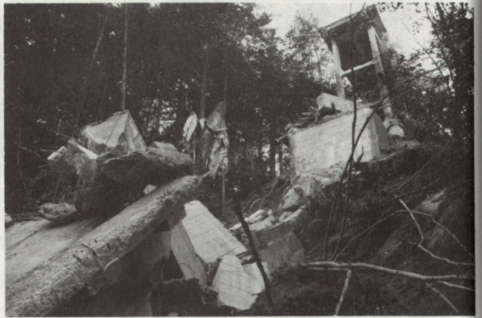
Gesprenge Brücke. Unser Verkehrsnetz ist zur Sprengung vorbereitet.
