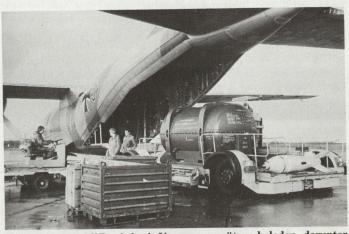
Lw-TransAll C-160D wird mit Versorgungsgütern beladen, darunter ein Triebwerksbehälter (Mitte). (Archiv AWK)
