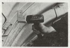
Bild 4. Verbindung der Ringnähte mittels Bolzenklammern.
