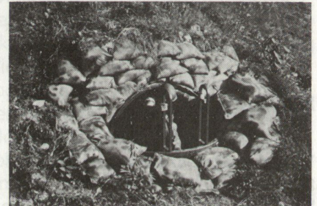
Bild 8. Fertig eingebauter Unterstand mit geradem Einstieg.
