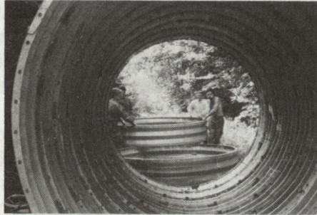
Bild 3. Zusammenbau der einzelnen Ringe zur Unterstandshülle.
