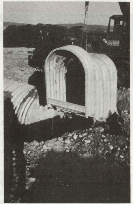
Bild 7. Anbau eines Winkeleinstieges an den Unterstand.
