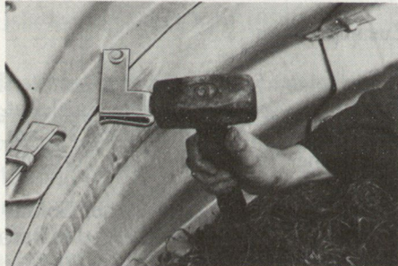
Bild 4. Verbindung der Ringnähte mittels Bolzenklammern.
