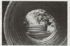
Bild 3. Zusammenbau der einzelnen Ringe zur Unterstandshülle.
