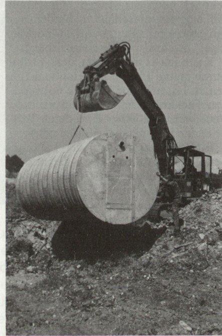
Bild 6. Absenken des Unterstandes mit bereits montierter Stirnplatte.
