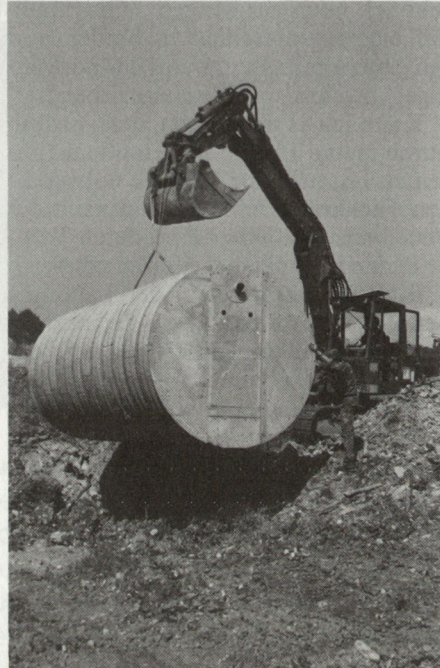
Bild 6. Absenken des Unterstandes mit bereits montierter Stirnplatte.
