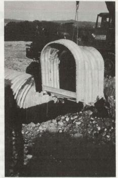
Bild 7. Anbau eines Winkeleinstieges an den
