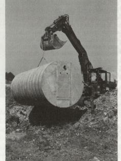
Bild 6. Absenken des Unterstandes mit bereits montierter Stirnplatte.
