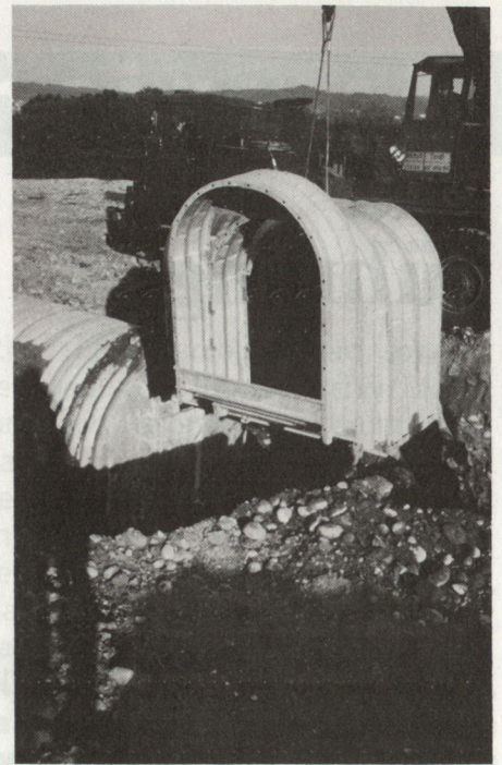
Bild 7. Anbau eines Winkeleinstieges an den Unterstand.
