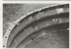
Bild 2. Mit Schnellverbindungselementen werden die einzelnen Wellstahlplatten zusammengefügt.
