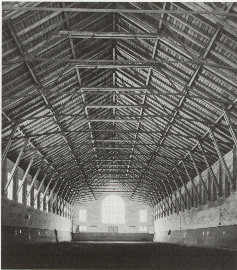
Blick in die alte Reithalle, in der das Armeemuseum entstehen soll.
