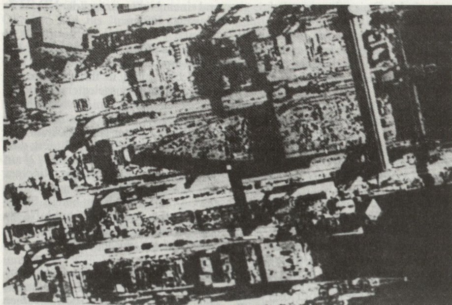
Bild 2. Das am 11. 8. 84 von «Jane's Defence Weekly» veröffentlichte Bild des im Bau befindlichen Trägers (5).
