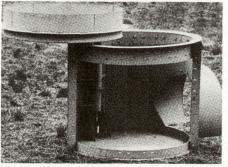
Feuerwalze leicht angehoben, so dass die Rundum-Beobachtung bei unvermindertem Schutz wieder aufgenommen werden kann. Im Augenblick des Waffeneinsatzes wird die Panzerluke um eine Vertikalachse weggedreht und gibt damit den Einsatz der Waffen frei.
