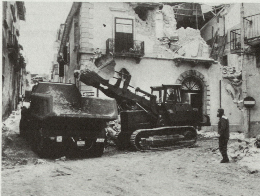
Einsatz von Baumaschinen im Erdbebengebiet Süditalien.
