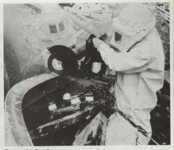
**Trennschleifgerät** Mit dem Trennschleifgerät können Metalleitungen und Armierungseisen durchtrennt werden.
