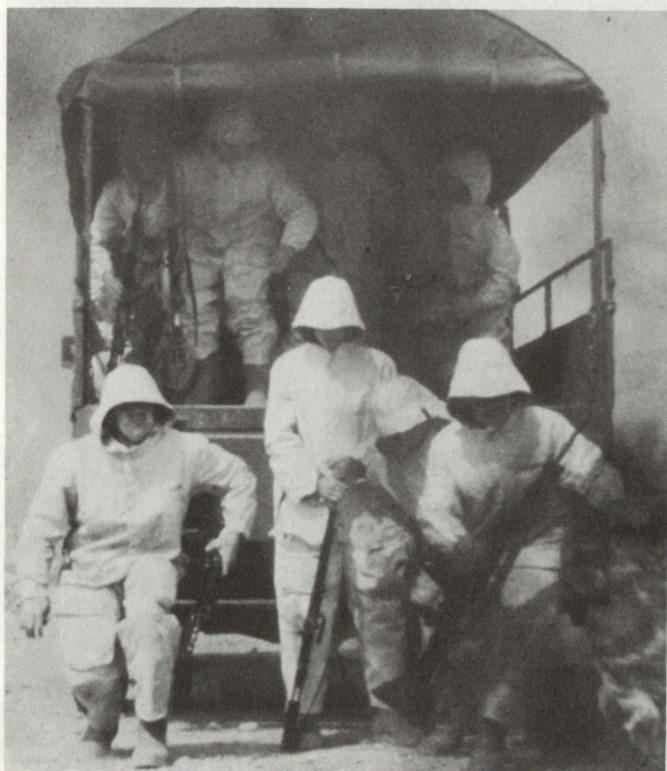
Ankunft im Schadengebiet. Die Luftschutzkompanie trifft am Einsatzort ein.
