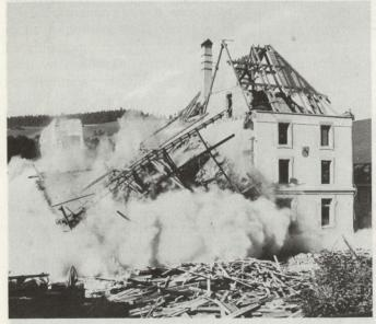
**Sprengungen**Sprengungen von labilen Gebäudeteilen im Rahmen der Wiederinstandstellungsarbeiten.
