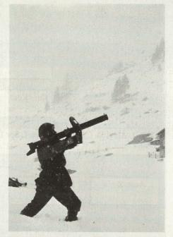
Künstliches Auslösen einer Lawine mit Raketenrohr.
