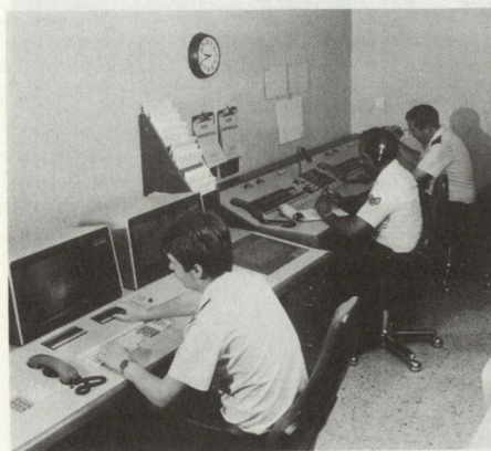
Blick in die Kurzwellen-Betriebszentrale des Projektes HF Replacement 4. ATAF (4. Alliierte Taktische Luftflotte). Im Vordergrund die zentrale Überwachungs- und Steuerungskonsole. Im Hintergrund die Kurzwellen-Überleiteinrichtung.
