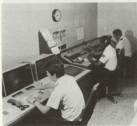
Blick in die Kurzwellen-Betriebszentrale des Projektes HF Replacement 4. ATAF (4. Alliierte Taktische Luftflotte). Im Vordergrund die zentrale Überwachungs- und Steuerungskonsole. Im Hintergrund die Kurzwellen-Überleitvorrichtung.
