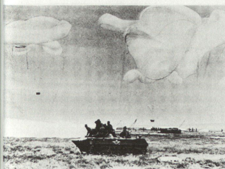
Landung von BMD-Luftlandpanzer auf Spezialpalette mittels Fallschirmen und Bremsraketen.
