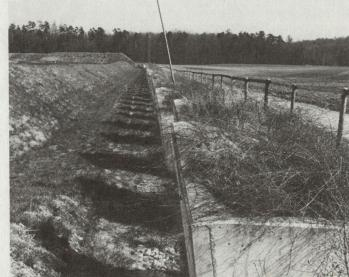
Bild 2. Die sogenannten Winkelstützelemente, die das Hindernis bilden, sind feindseitig in der Regel durch einen Wall der Sicht entzogen. In Wildensbuch sollen sie in eine Mulde verlegt werden.
