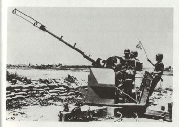
Die Bofors L/70 ist ein radarisierter Einling. Sie hat eine höhere Feuergeschwindigkeit als die L/60 und doppelte Kadenz. Die Munition besitzt neuerdings Annäherungszünder. Als Radar wird im NATO-Bereich die Super-Fledermaus eingesetzt.
