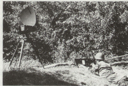
Bild 2. Rasit, Mitte der siebziger Jahre entwickelt, ist tragbar, wiegt weniger als 80 kg und verbraucht nur 130 W, leistet jedoch dasselbe wie frühere Radars.
