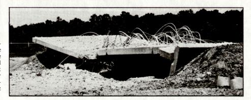
Die Stahlbetonbrücke vor der Sprengung (oben). Links vom Mittelträger, unter dem hell markierten Teil der Brücke, die angebrachte Schneidladung. Darunter: Nach der Sprengung.
