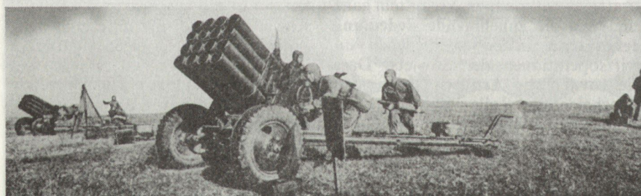
Bild 7. 140-mm-Raketenwerfer BM-14/16, der auch von Hand gezogen werden kann und besonders für Luftlandetruppen gebaut wurde.
