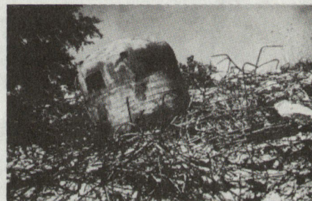
Abb. 9: Wirkung der deutschen 8,8 cm im Direktschuss gegen französische Bunker
