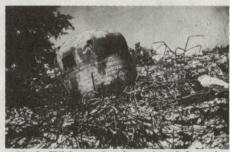
Abb. 9: Wirkung der deutschen 8,8 cm im Direktschuss gegen französische Bunker
