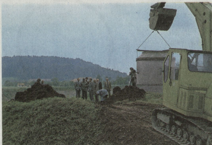
Bild 6. Transport der vorfabrizierten Stellung vom Lastwagen zum Einbauort
