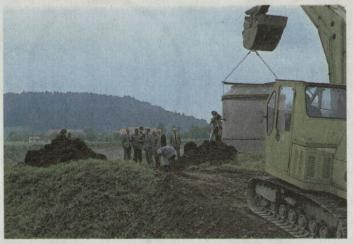
Bild 6. Transport der vorfabrizierten Stellung vom Lastwagen zum Einbauort
