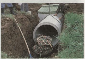
Bild 7. Eingebaute, noch nicht hinterfüllte Waffenstellung mit Anschlussrohr ( $\varnothing_i = 1000 \text{ m}$ )
