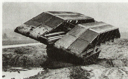
Bild 2. Brückenpanzer 61 mit MAN-Genieschiebebrücke
