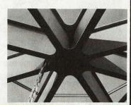
Casino in Montreux, Dachkon-struktion: Die 8 Hauptträger sind zu einem eindrücklichen Stern verbunden
