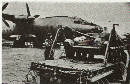
Bild 2. ASU57 werden für Abwurf aus AN12 vorbereitet.
