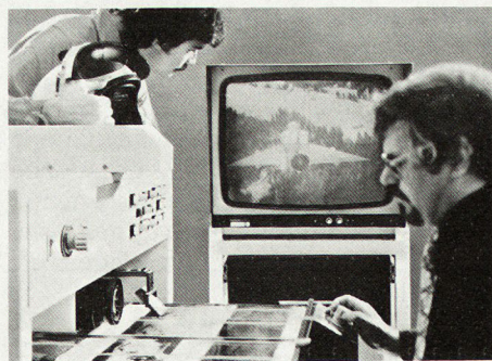
Bild 1. Elektronisches Luftbildauswertesystem «Revi II». Schnelle und präzise Auswertung von Schwarz-Weiß-Luftbildnegativen aller Art.
