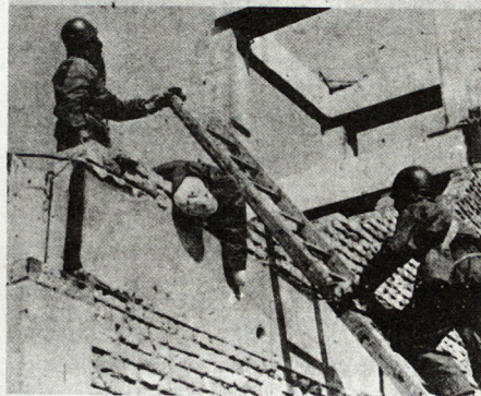
Zivilverteidigung in Ungarn. Jährlich werden in verschiedenen Orten großangelegte Manöver abgehalten.
