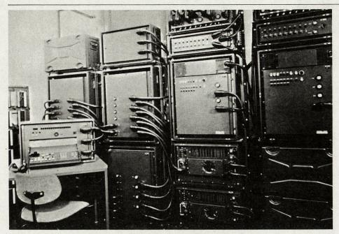
Fig. 8. Ausführungsbeispiel einer Knotenzentrale für 128 Anschlüsse.
