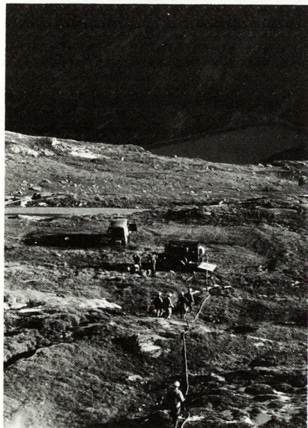
2 Installationsplatz mit Kompressor; Legen der Druckluftleitung.
