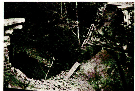
Objekt nach der Sprengung. Deutlich sichtbar die Sandsteinbrocken- und Kieshinterfüllung der Seitenmauern.
