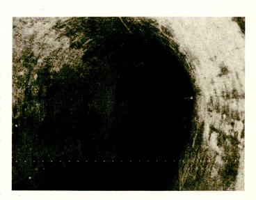
Arbeitsplatz: «Kanalisationsübung». Ort: Schermenweg. Blick in die Kanalisation. Zementrohr Eiprofil, Höhe 150 cm.
