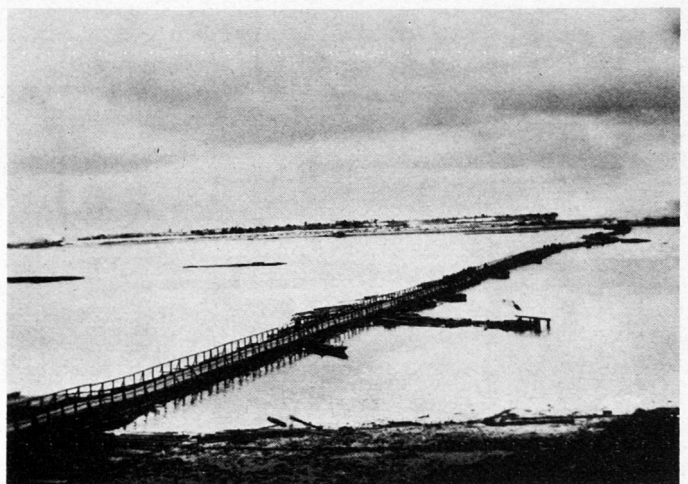
3. Die von den Sowjets erbaute Schwimmbrücke über den Dnjepr.
