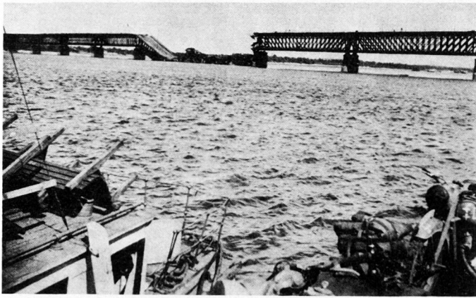
2. Die Doppelstockbrücke in Dnjepropetrowsk mit Sprengstück.
