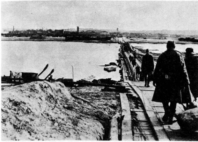
1. Teilstück der Schwimmbrücke von der Sandbank bis zum Ostufer des Dnjepr.
