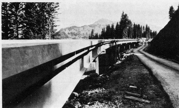
Bild 4 Schießplatz Petit Hongrin. Erschließungsstraße. Vorfabrizierter Viadukt, Länge 108 m, Radius 200 m, 9 Spannweiten zu 12 m. Erstellt in 9 Arbeitstagen. Rechts die Werkstraße.
