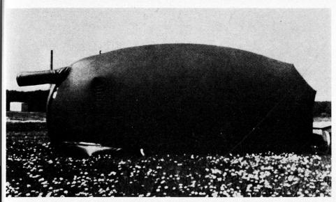
Bild 1. Kampfpanzer «Leopard» in Dauerverpackung, Hülle durch Überdruck aufgebläht.
