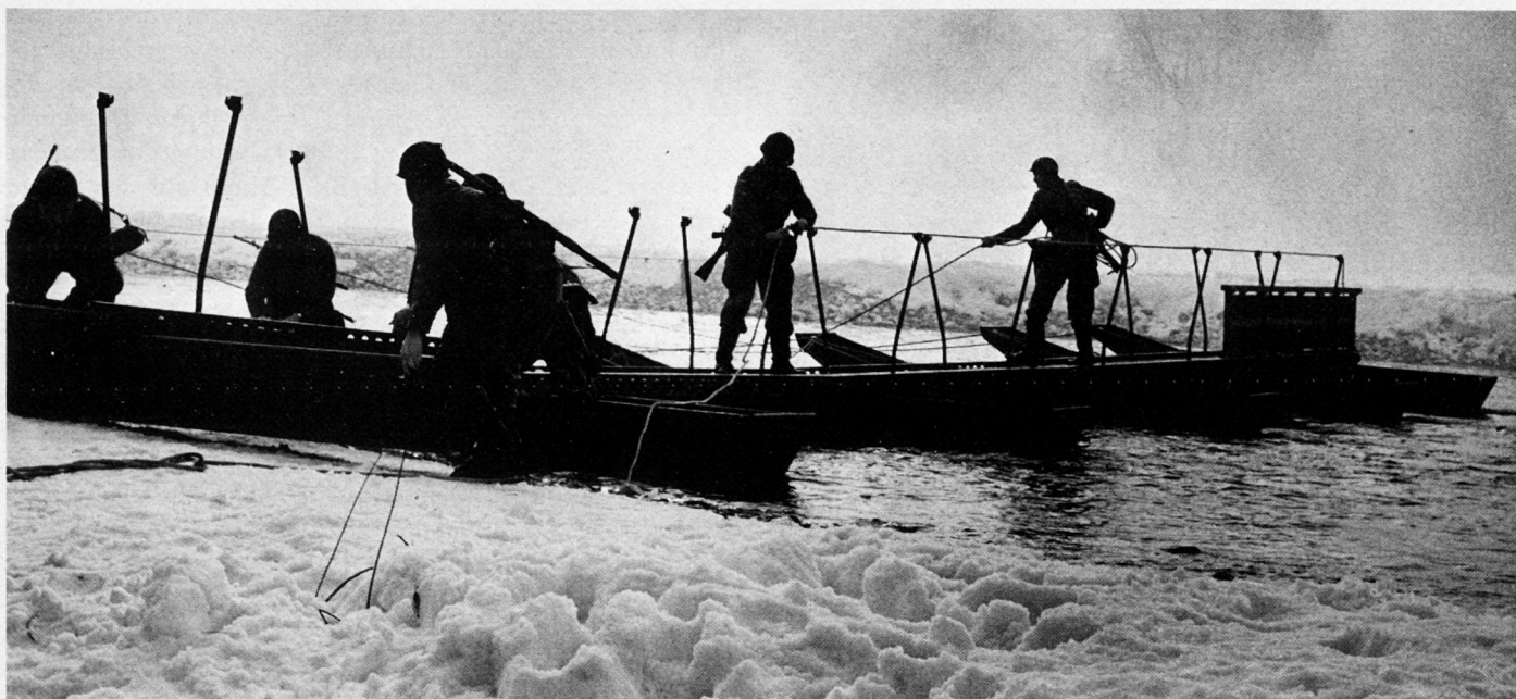
Bild 30. Deutsche Bundeswehr, Gebirgspioniere beim Bau eines Infanteriesteges.
