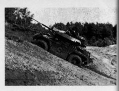
Bordmaschinenkanone 30 mm «Rarden» und Maschinengewehr; 3 Mann Besatzung; Prototypen gegenwärtig im Truppenversuch. bb («Soldat und Technik» Nr. 12/1969)
