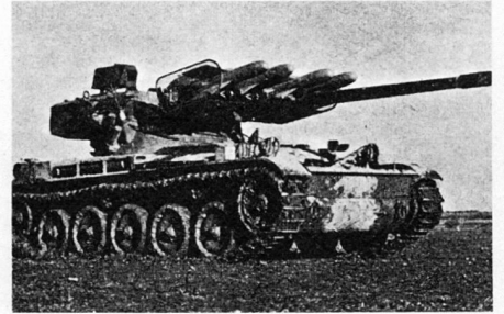
Bild 3. Jagdpanzer AMX 13, Kanone 75 mm und Raketen SS 11 B1.
