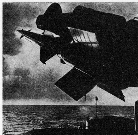
Startarm hängende GOA an Bord eines sowjetischen Überwasser-Flugkörperträgers (vermutlich eines Raketenträgers der «Kresta»-Klasse). Die GOA hat ein verhältnismäßig kleines Gewicht und eine Reichweite von etwa 20 km. bb
