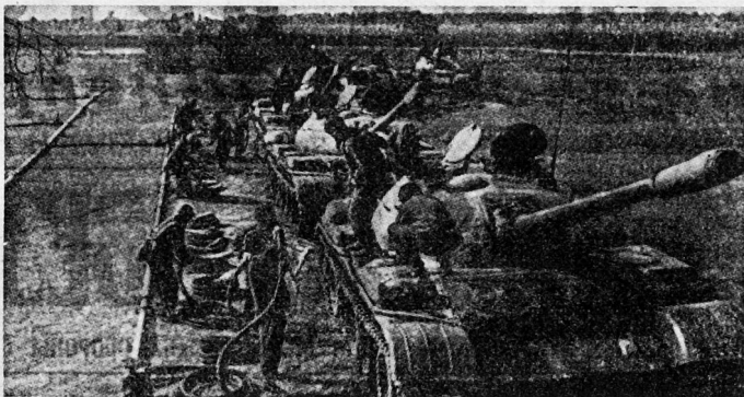
Bild 17. Panzerfahrzeuge werden direkt aus den Feldrohrleitungen aufgetankt.
