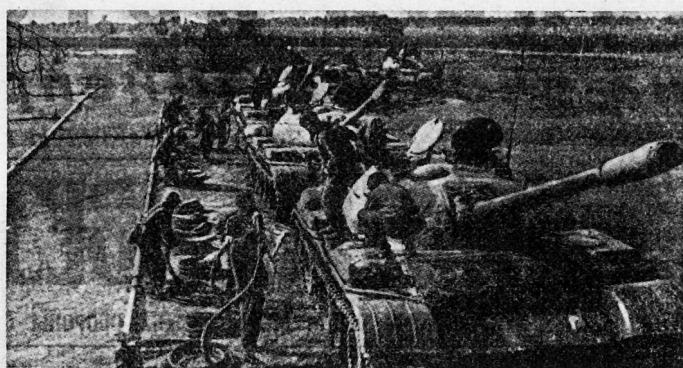
Bild 17. Panzerfahrzeuge werden direkt aus den Feldrohrleitungen aufgetankt.
