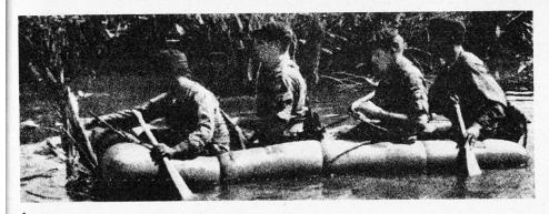
Kunststoffboot. Für Spähtrupp- und Kommandoeinsätze wurde ein auf blasbares Kunststoffboot von nur 2,7 kg Gewicht entwickelt. Das Boot besteht aus 10 Zellen, die von der Besatzung in 5 Minuten aufgeblasen werden können. Die Tragfähigkeit beträgt 4 Mann oder 453 kg. Im aufgeblasenen Zustand betragen die Abmessungen 2,74 m Länge, 96 cm Breite und 25 cm Höhe. Zusammengefaltet ist das Paket 38 × 25 × 15 cm groß. Die Stabilisierung erfolgt durch Wasserballast.
