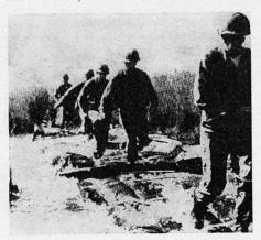
eingeschoben werden. Mittels Wurfankern mit Seilauge wird der Schnellsteg ans andere Ufer gezogen.
