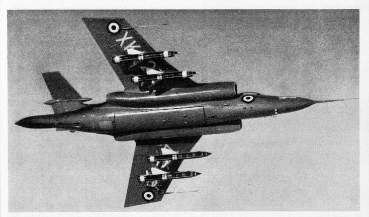
Bild 3. Kampf- und Aufklärungsflugzeug, zweisitzig, zwei Triebwerke und Starthilferaketenantriebwerk. Geschwindigkeit im Tiefflug (60 m/ Boden) Mach 0,85, als optimaler Wert für den Anflug auf Bodenziele. Im Einsatz bei der Royal Navy und von diesem Jahr an bei der RAF.
