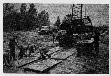
Bild 9. Eine durch Regen zerstörte Straße wird mit Hilfe spezieller Straßenbelagsschilder wieder fahrbar gemacht. (28. Juli 1968.)
