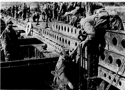
Bild 3. Tschechische Pioniere beim Bau einer Pontonbrücke, wobei es sich eher um veraltetes Material handelt.
