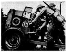
der wiederum auf ein zweirädriges Fahrgestell mit Spreizlafette montiert ist. Der Höhen- und Seitenrichtmechanismus sowie die optischen Geräte befinden sich an der linken Seite des Rohrblockes. Die Grundkonzeption des Werfers erinnert an die tschechoslowakische Ausführung auf Lastwagen. Die Geschosse sind drallstabilisiert.
