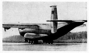
Bild 1. An 22, genannt «Antäus», hat eine Reihe von Weltrekorden aufgestellt, so zum Beispiel erreichte dieses Flugzeug mit 88 t Gewicht eine Höhe von 6500 m. Dieses Flugzeug von Oleg Antonow, das jetzt in Serie produziert wird, ist schon seit der 26. Internationalen Luft- und Raumfahrtausstellung in Paris bekannt. Das Flugzeug entwickelt mit seinen vier Turboprop-Triebwerken eine Geschwindigkeit von 740 km/h.
