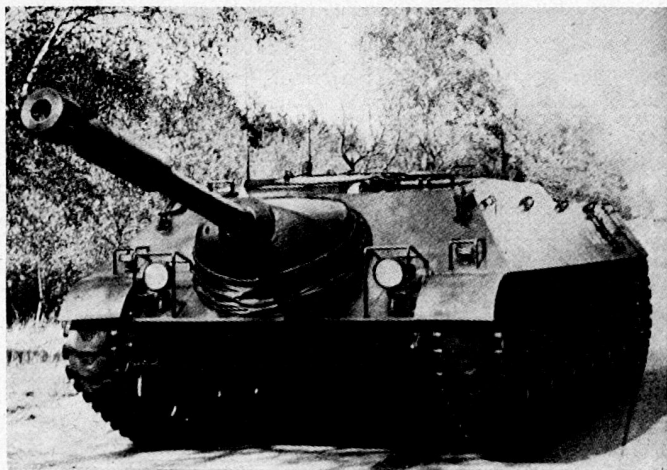
Bild 4. Der deutsche Kanonenjagdpanzer mit einer 90-mm-Panzerabwehrkanone – der moderne Panzerjäger der deutschen Bundeswehr.
