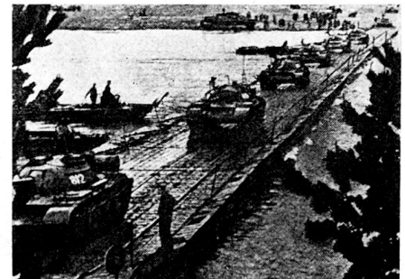
Bild 3. Die fertige Pontonbrücke PMP (150 m lang).
