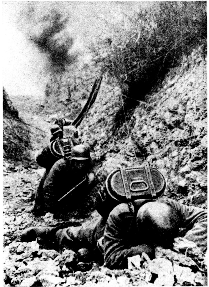
Bild 3. Deutsche Essenholer im Fort Balaklawa suchen Schutz vor Granaten.
