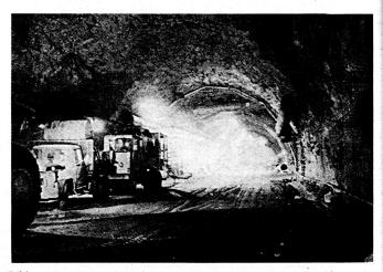
Bild 4. Ein Eingangstunnel zum NORAD-Hauptquartier im Cheyennegebirge während des Baus. Der Haupteingang ist 8,85 m breit und 7 m hoch. Das Werk hat 18580 m² Bodenfläche.
