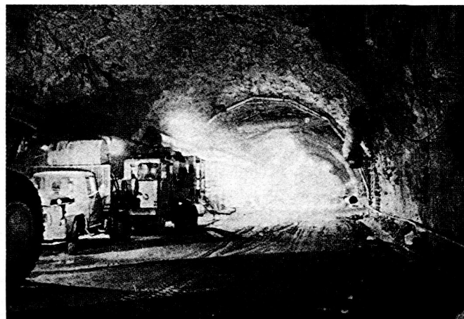
Bild 4. Ein Eingangstunnel zum NORAD-Hauptquartier im Cheyennegebirge während des Baus. Der Haupteingang ist 8,85 m breit und 7 m hoch. Das Werk hat 18 580 m 2 Bodenfläche.
