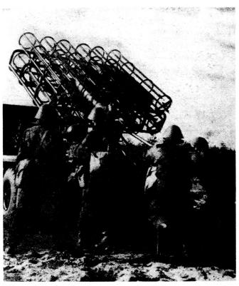
Bild 7. Geschoßwerfer der sowjetzonalen Volksarmee. In wenigen Minuten muß er mit 12 zentnerschweren Raketen geladen werden. Zweckmäßigerweise geschieht das im Bereitschaftsraum. Die Werfer werden geladen in die Feuerstellung gefahren, damit eine schnelle Feuereröffnung möglich ist.
