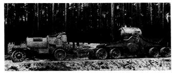
Bild 2. Generator-Zugwagen mit Anhänger, 42-cm-Lafetten-Wagen. Auch diese Einheiten waren wie jene der 38-cm-Motor-Haubitzen für Straßen- und Schienenfahrt (im letzteren Falle für max. 27 km/h) eingerichtet. Größte Achsbelastung 9½ t. (Archiv Heeresmuseum, Wien.)
