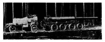
Bild I. Generator-Auto (Zugwagen 150 PS für Fortbewegung im Straßen- oder Schienenbetrieb mit eigener Kraft) sowie 24-cm-Kan.Rohr L/40, M16; durch wahlweisen Austausch der Räder konnten diese Einheiten in kurzem jeweils für Straßen- wie auch für Schienenfahrt eingerichtet werden. Die im Text erwähnten 38-cm-Motorhaubitzen M16 waren in ganz ähnlicher Weise ausgestattet. (Photo: Heeresmuseum, Wien.)
