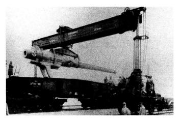
Bild 6. 35-cm-Kan.Rohr L/45 wird mit 100-Tonnen-Kran hydraulisch (2 Hubwagen) vom Transportwagen gehoben (Zeit des I. Weltkrieges). (Archiv Heeresmuseum, Wien.)
