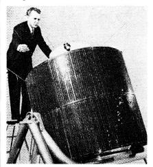
Bild 4. ATS-Wettersatellit für synchrone Umlaufbahn.
