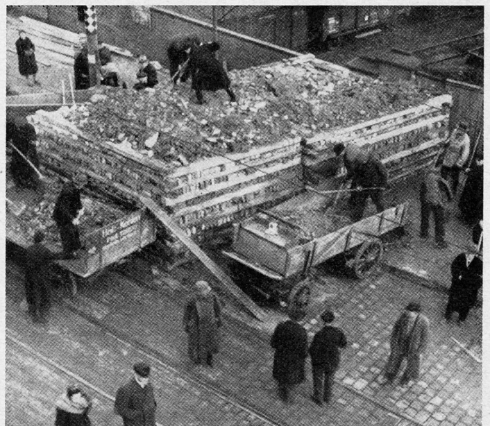
Bild 12. Zwischen Oder und Reichskanzlei werden vom Februar 1945 an zahlreiche Schützengraben, Panzersperren und Bunker errichtet.
