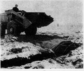
Bild 6. Bagger «Matenin» beim Überdecken des Unterstandes.
