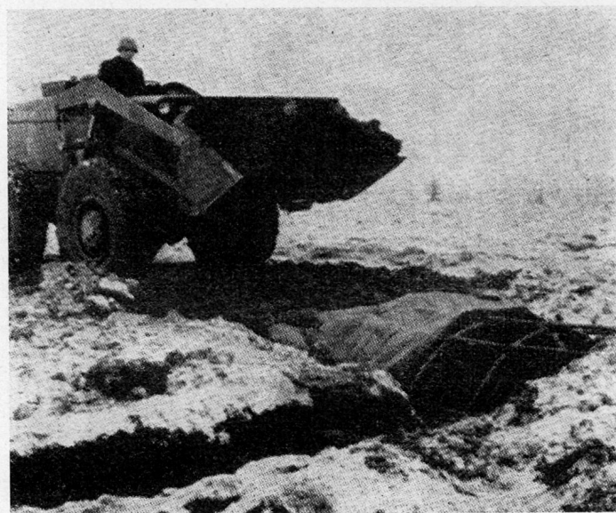
Bild 6. Bagger «Matenin» beim Überdecken des Unterstandes.
