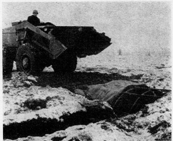
Bild 6. Bagger «Matenin» beim Überdecken des Unterstandes.
